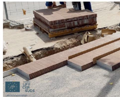
PROGETTO CERSUDS ESECUZIONE DELLA POSA IN OPERA DEL DIMOSTRATORE - INSTALLAZIONE DEI MODULI CERAMICI
